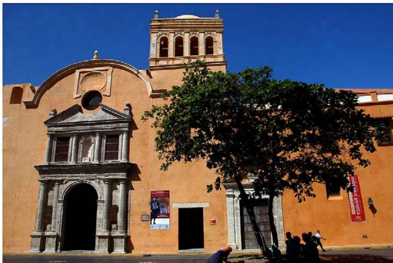
IGLESIA Y CLAUSTRO DE SANTO DOMINGO
